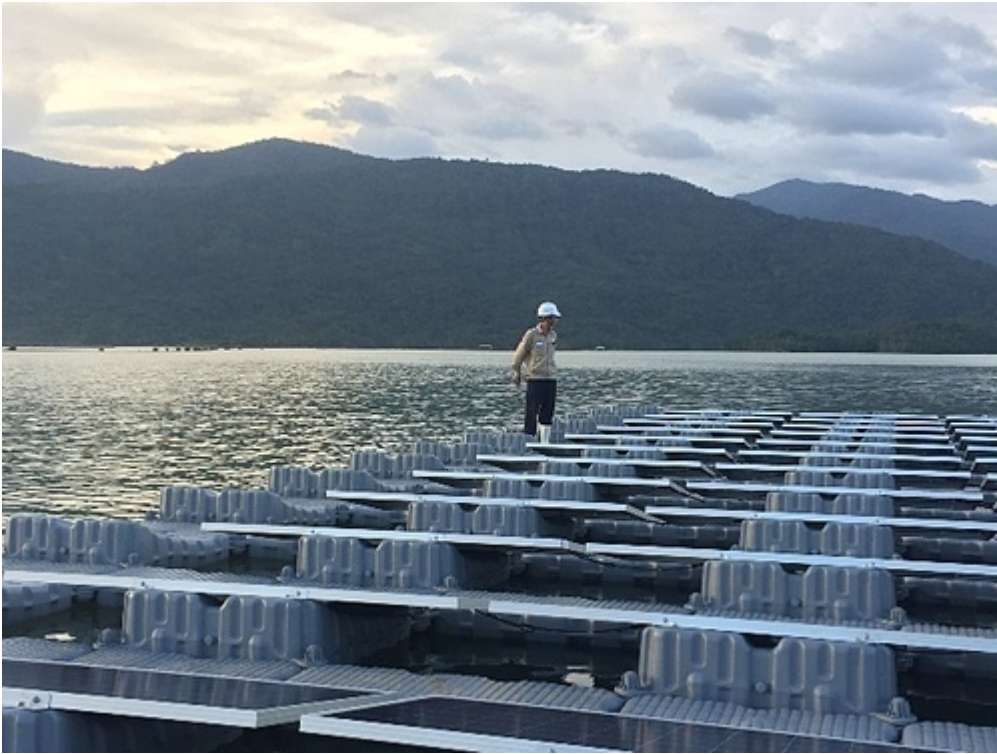
Công nhân kiểm tra hệ thống phao tại Dự án Nhà máy Điện mặt trời nổi hồ Đa Mi.
