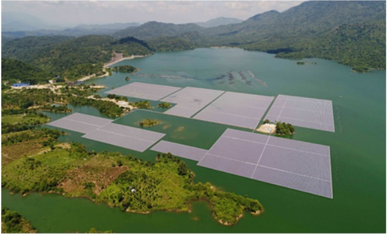
Hệ thống phao neo được lắp đặt hoàn chỉnh trên hồ Đa Mi.
