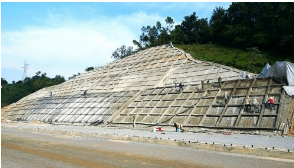
Một công trình thi công bảo vệ mái dốc tuyến cao tốc Bắc Giang - Lạng Sơn.
